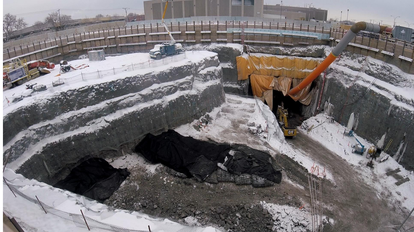
Exemple d'utilisation des matelas lors d'un sautage contrôlé
