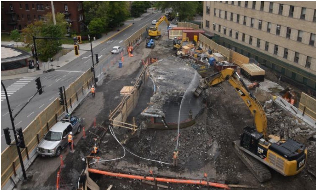
Mi-août: Démolition de l'édicule du métro
