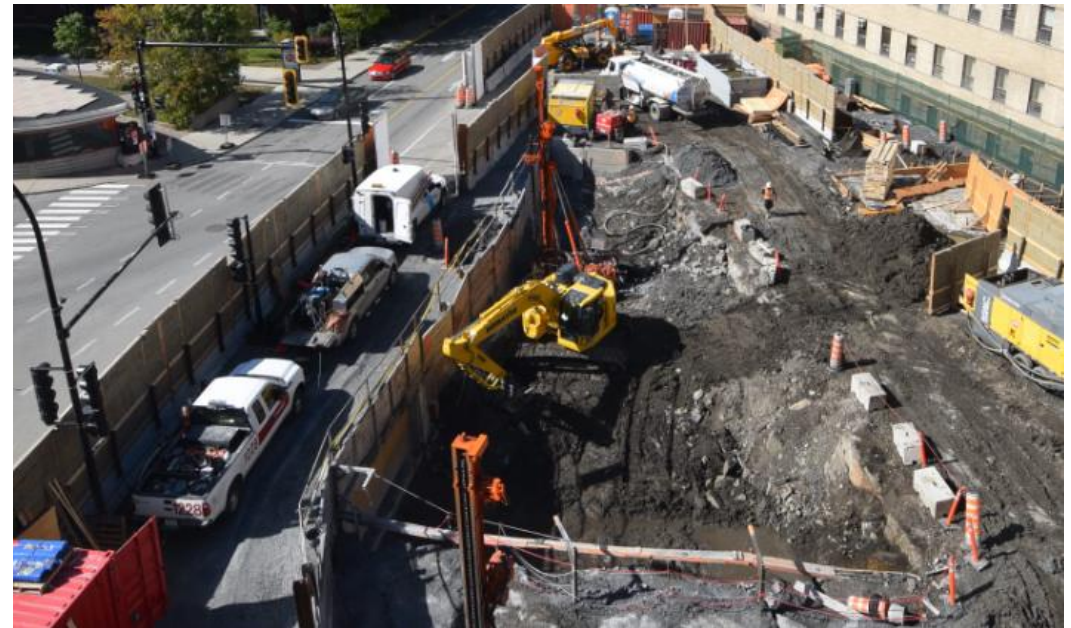
Septembre : Début des forages pour préparer le sautage contrôlé
