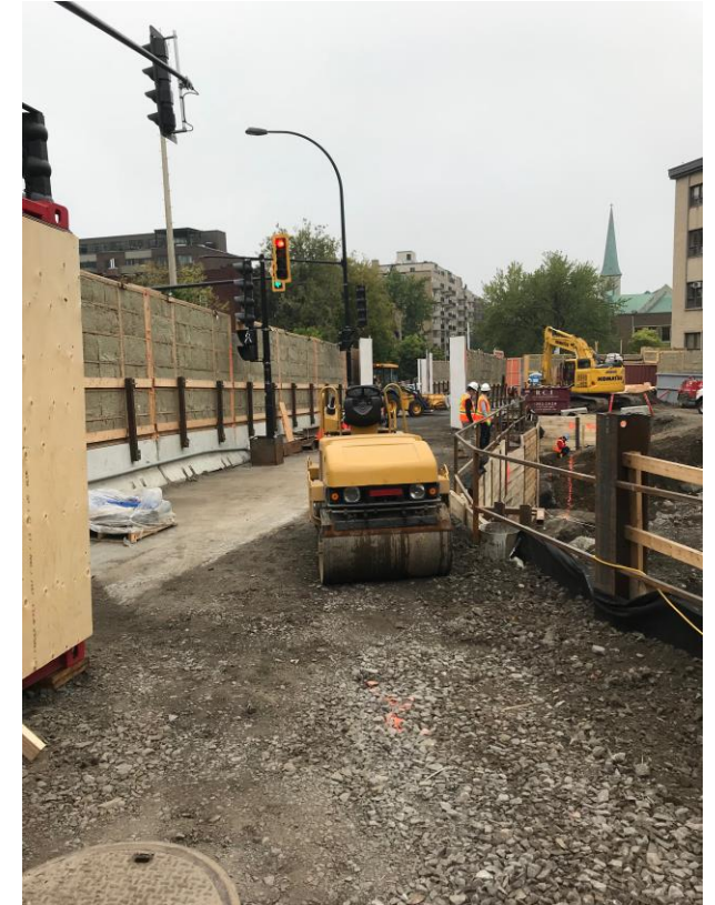
Pavage du couloir de camion
