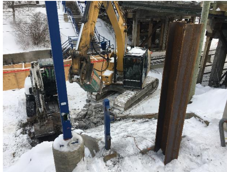
Démolition du quai et escalier à Mont-Royal
