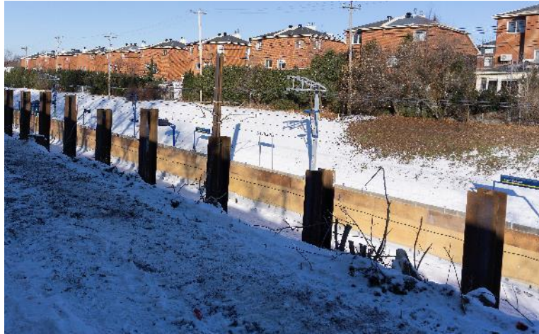
Vibro-fonçage et battage de pieux des murs de soutènement
