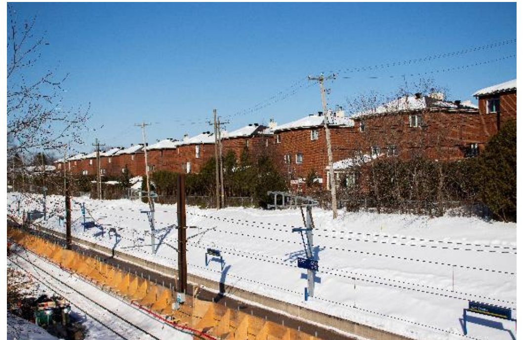
Modification d'une ligne électrique et de haubans de télécommunications
