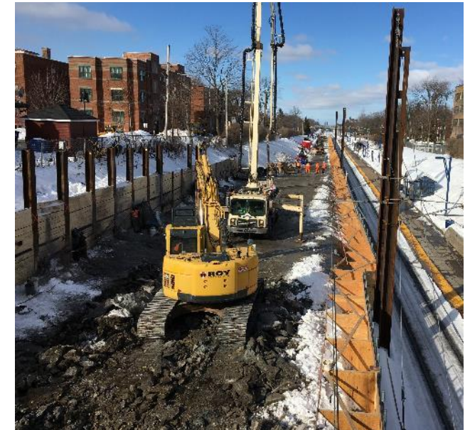
Excavation du remblai et boisage des murs de soutènement
