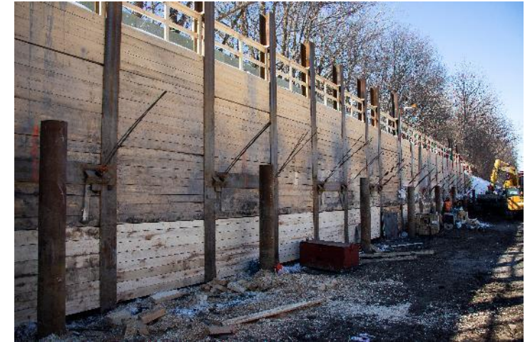
Ancrage du mur de soutènement
