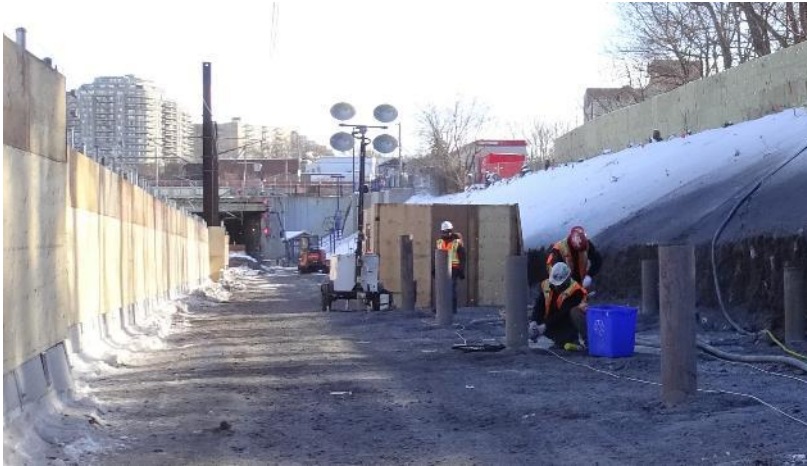
Forage de pieux pour les stations
