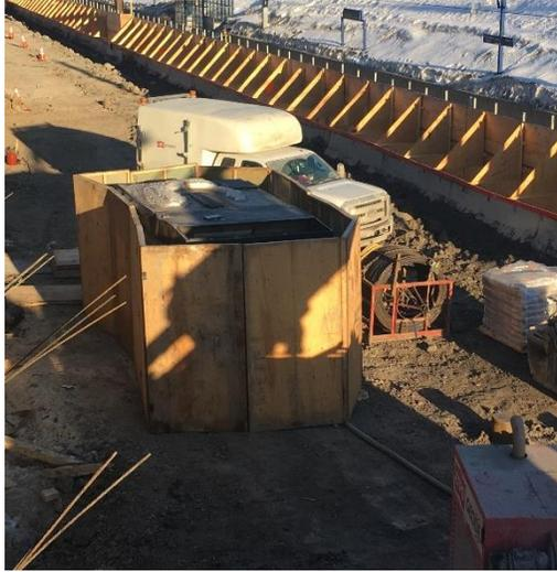
Caisson acoustique installé autour d'un compresseur
