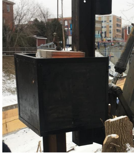
Caisson acoustique autour du marteau lors de vibrofonçage de pieux
