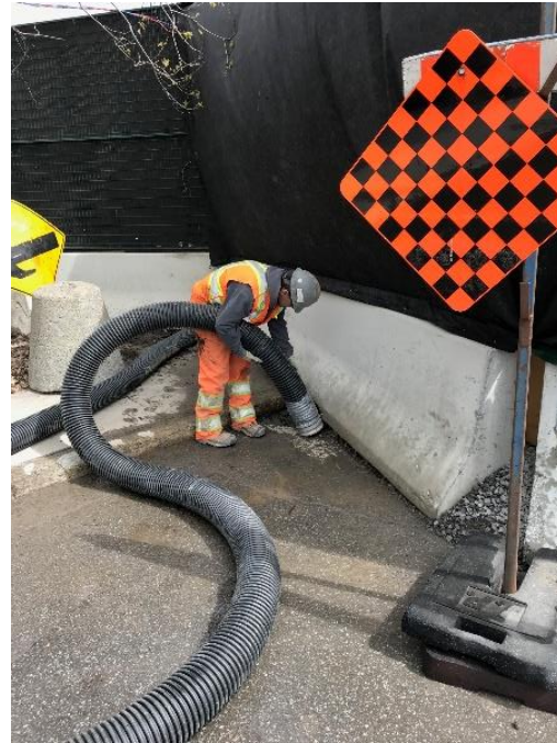
Entretien autour des glissières de béton
