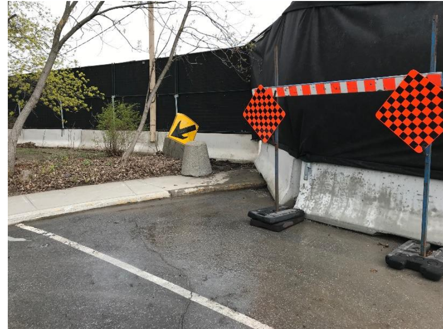
Géotextile sur les clôtures
