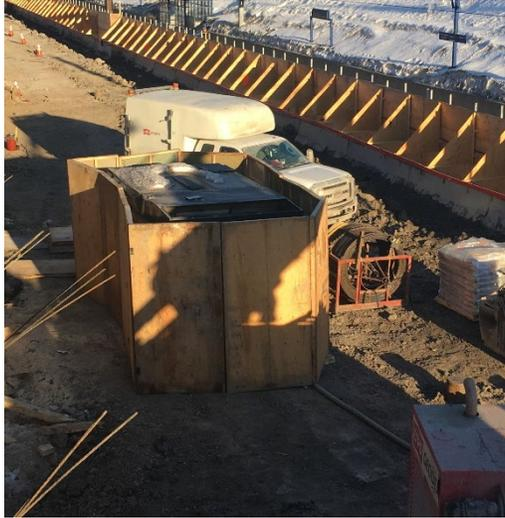
Caisson acoustique installé autour d'un compresseur
