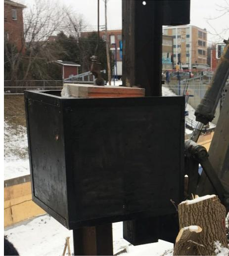
Caisson acoustique autour du marteau lors de vibrofonçage de pieux
