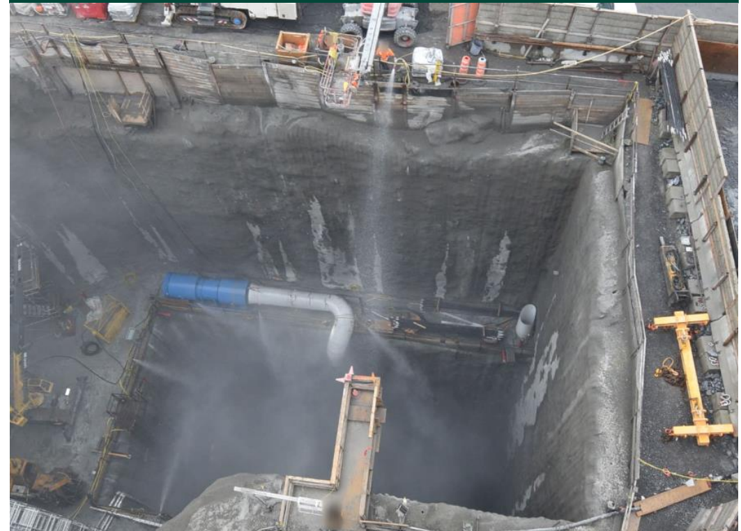
6 brumisateurs en place
