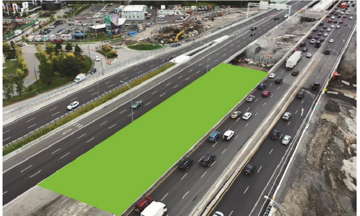
Île-des-Sœurs Station – Centre of highway
