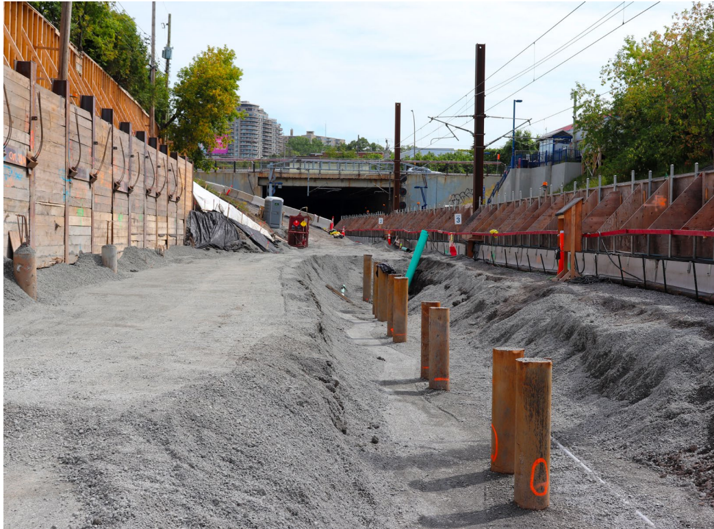
Forage des pieux de fondation Canora est
