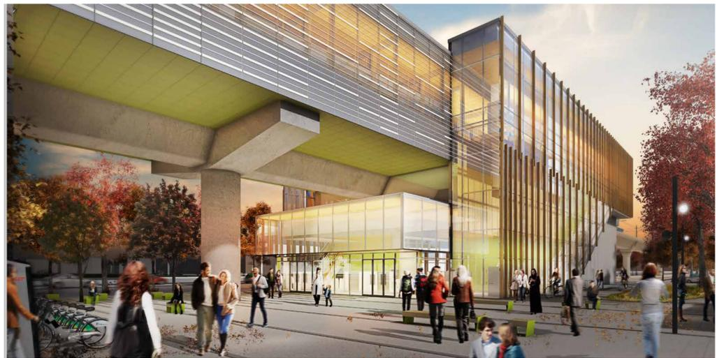
Les stations sont transparentes, pour un maximum de luminosité naturelle et de sécurité (la notion de voir et d'être vu). Le verre fritté est utilisé pour filtrer la lumière.
