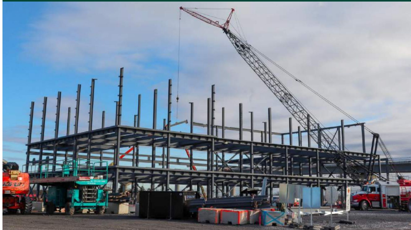
Exemple d'une structure d'acier extérieure – Centre d'entretien Rive-Sud
