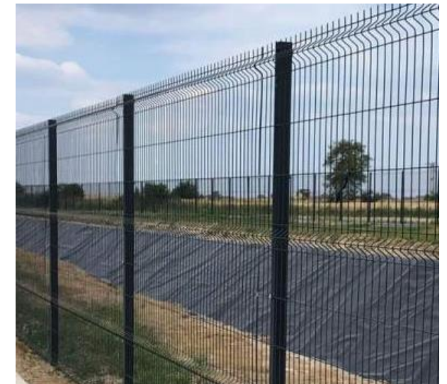
Nouvelle clôture anti-intrusion
