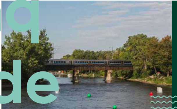
Pont ferroviaire à Laval
