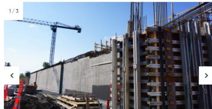
Fondations de la station Île-Bigras (automne 2021)
