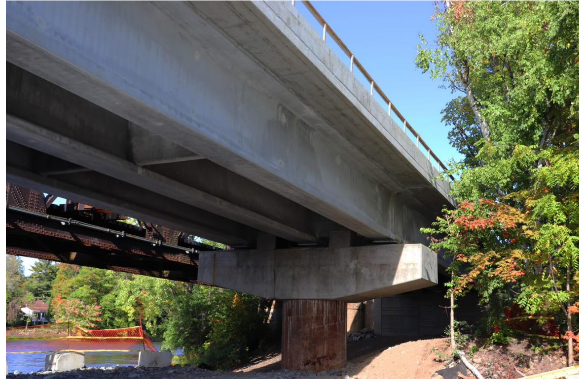
Vue « sous » RDP1
