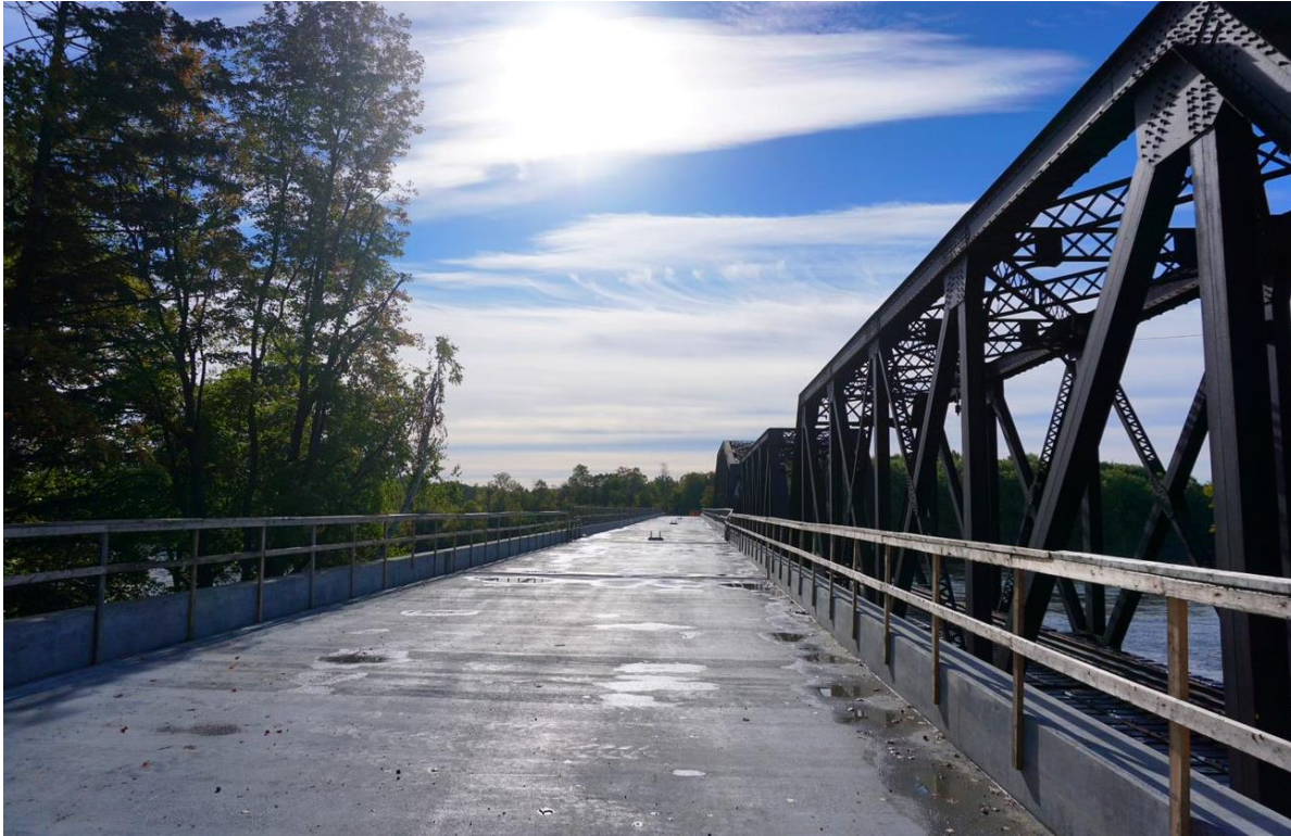
Vue « sur » RDP1
