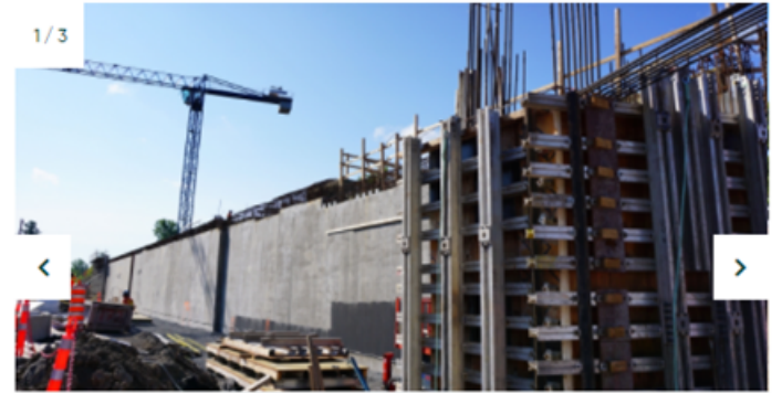
Fondations de la station Île-Bigras (automne 2021)
