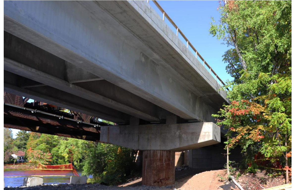
Vue « sous » RDP1
