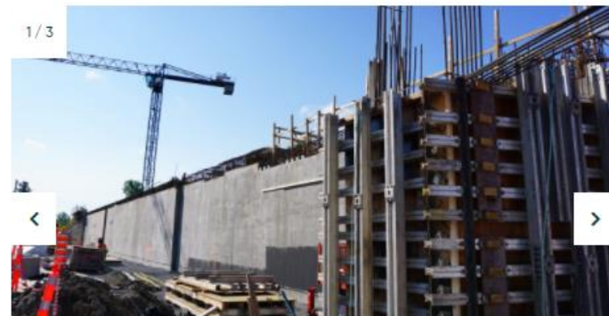
Fondations de la station Île-Bigras (automne 2021)
