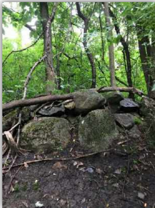
Photographie 2 — Barrière de blocs rocheux en bordure du Tronçon 1
