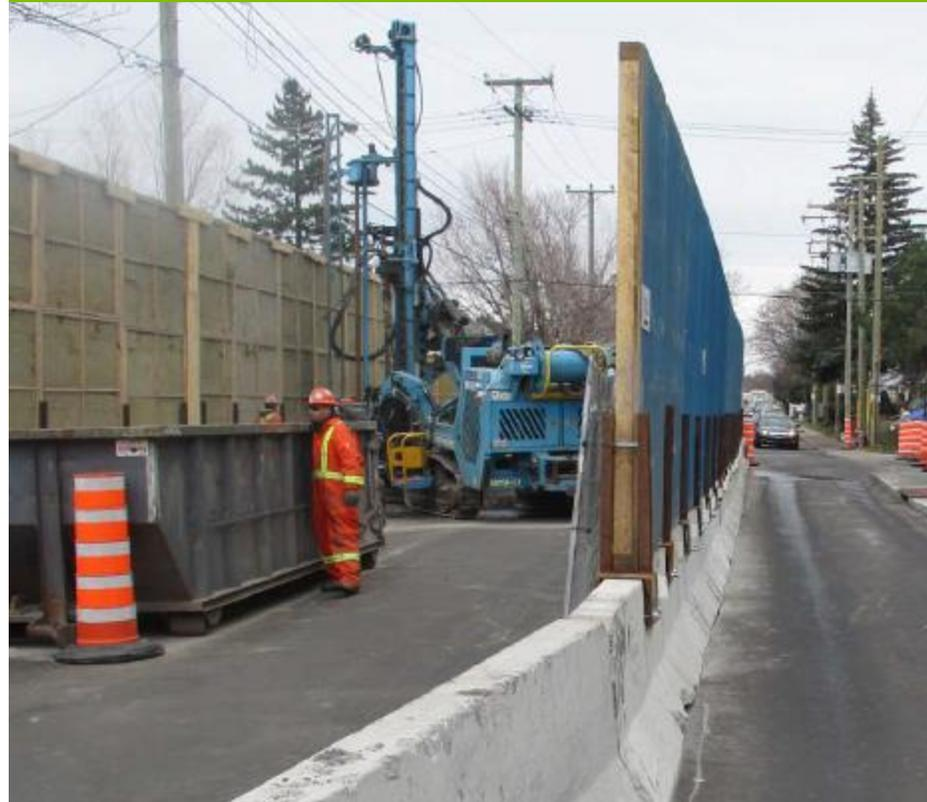
Utilisation d'une benne basculante pour extraire les déblais et les charger dans les camions
