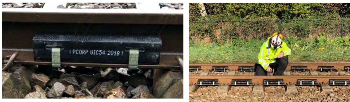
Figure 5 : Exemple d'absorbeurs dynamiques « Tuned Rail Damper »
