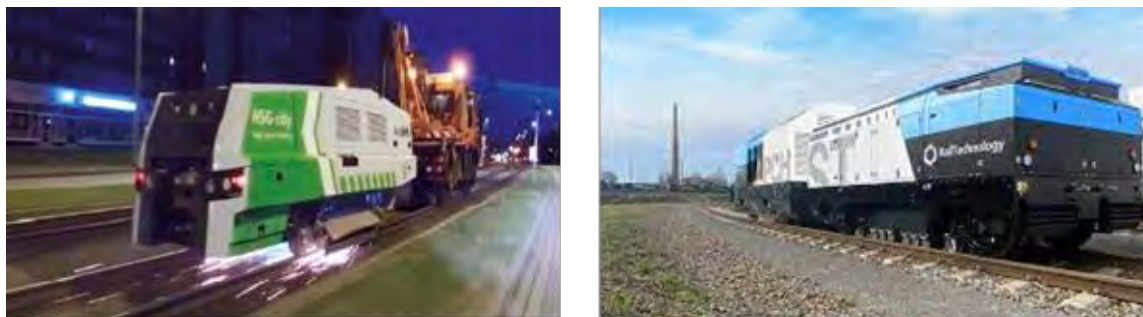
Figure 3 : Opération de meulage pour maintenance de l'état de surface des rails. Sources : Vossloh / RailTechnology
