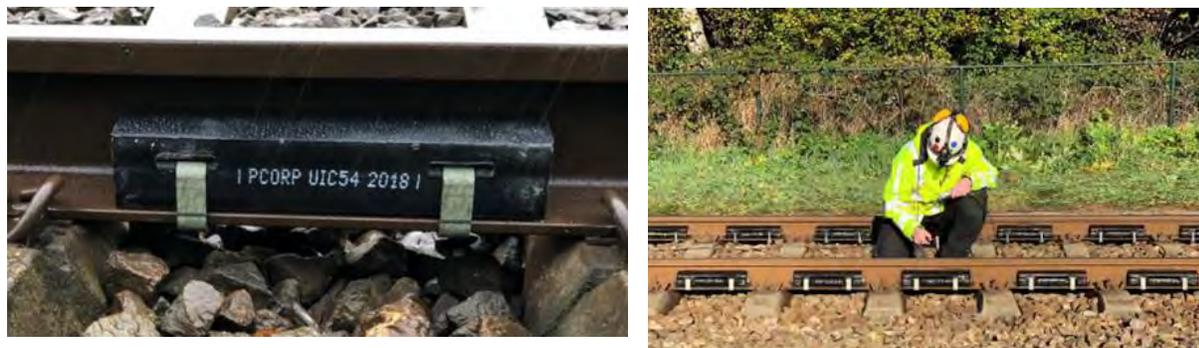
Figure 5 : Exemple d'absorbeurs dynamiques « Tuned Rail Damper »
